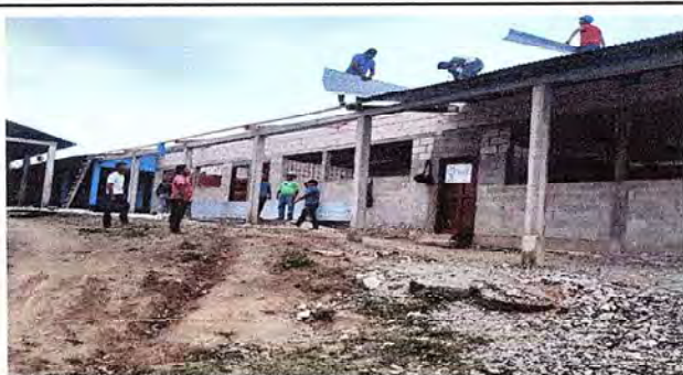
Foto 1: Cambio de láminas
