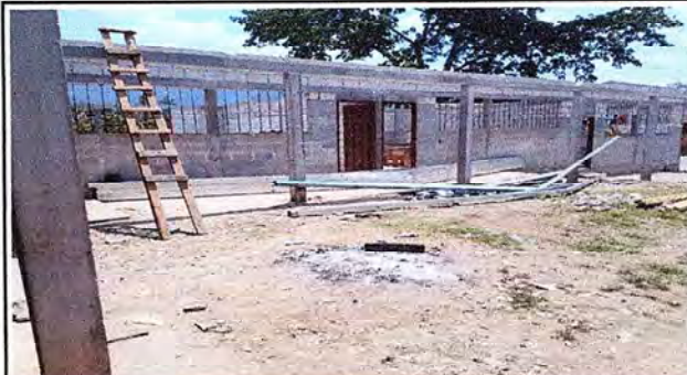
Foto 2: colocacion de reglas
