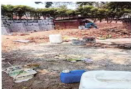
Foto 5: colocacio deb block
